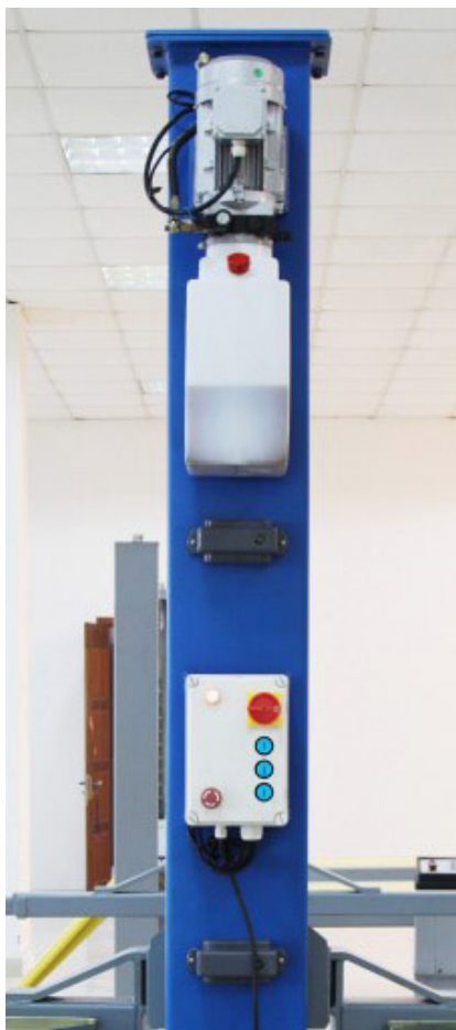
Рис. 2.2 – Установка гидростанции и блока управления
